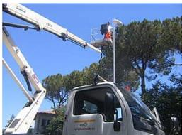
Trattasi di interventi di manutenzione della pubblica illuminazione e degli impianti semaforici mediante l'esecuzione delle operazioni necessarie a garantire il corretto funzionamento dell'impianto, quali:
