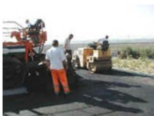
La fase di lavoro prevede la finitura della pavimentazione in asfalto da: conglomerato bituminoso (tappetino), stesi a caldo e di vario spessore. I vari strati sono stesi con vibrofinitrice, e/o a mano, previo scarifica della pavimentazione ammalorata, spandimento di bitume liquido su sottofondo già predisposto.
