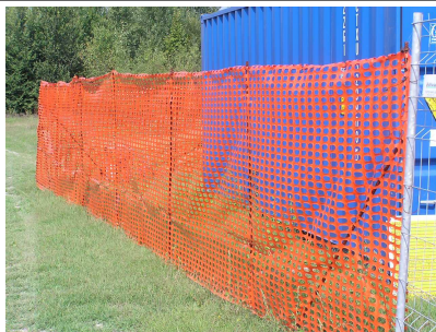
fig. 4.1 – rete plastificata su rete metallica su supporto in cls
