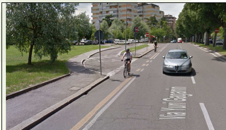
Corsia ciclabile monodirezionale in carreggiata senza sosta, con trattamento passo carraio (Bologna, via Gagarin. La dimensione minima di corsia è di 110 cm. (al netto della segnaletica).
