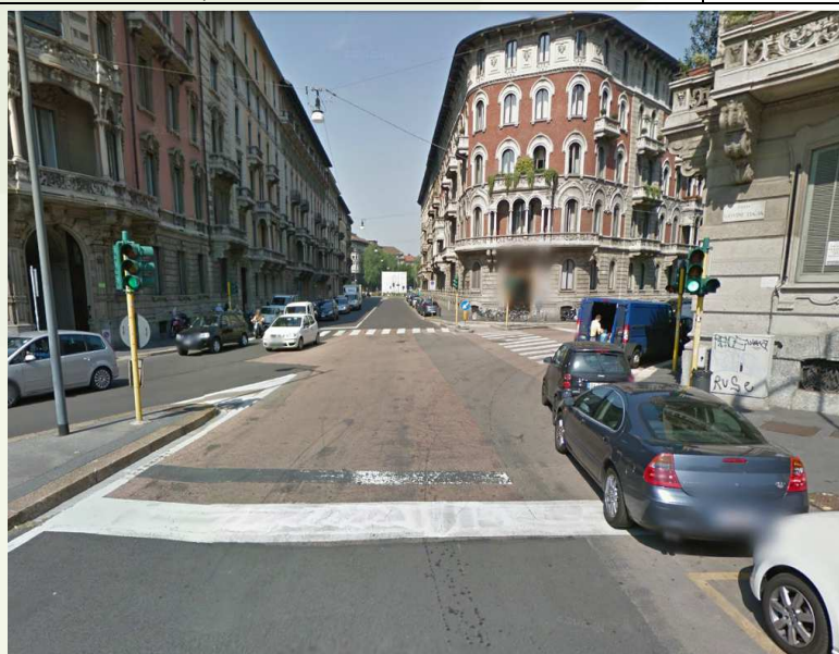
Milano, via Inganni. L'isola non è sufficiente per garantire il ricovero al ciclista, costringendolo ad invadere l'attraversamento pedonale
