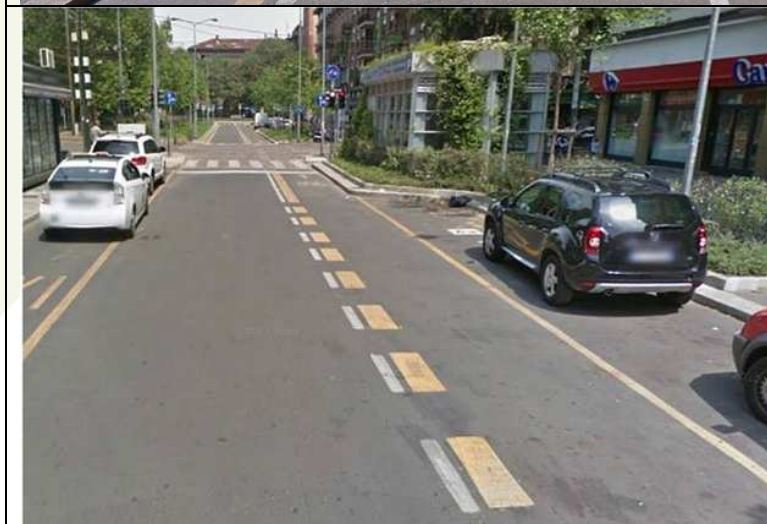
Corsia ciclabile monodirezionale con sosta laterale (Milano). La dimensione minima della corsia è di 130 cm. per tener conto del maggior franco richiesto dalla sosta. La sosta deve essere longitudinale o, se inclinata, con accesso retroverso (cfr.par.4.7)
