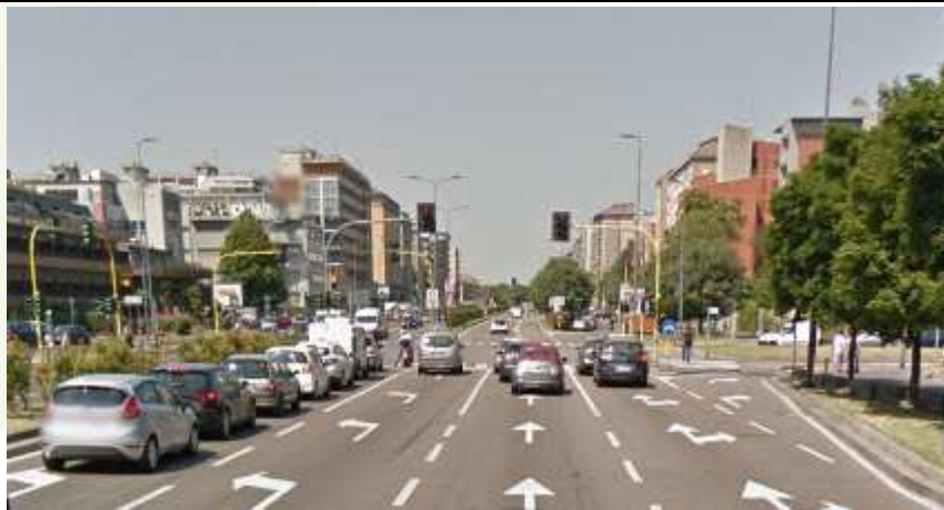
Milano, viale Cermenate. La doppia corsia di svolta a sinistra 'pura' ne consente l'uso anche all'eventuale ciclista. Da notare anche il disegno 'accettabile' della corsia per la svolta a destra continua.
