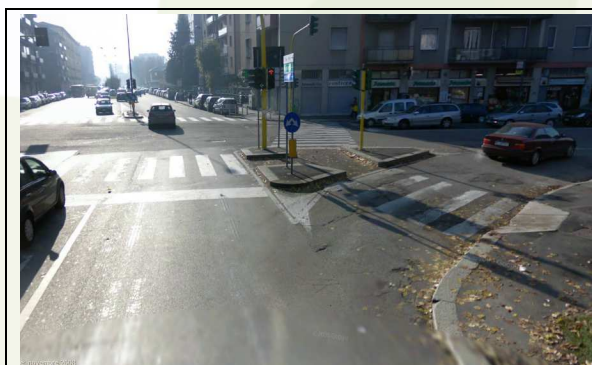
Milano, via Inganni. L'isola non è sufficiente per garantire il ricovero al ciclista, costringendolo ad invadere l'attraversamento pedonale
