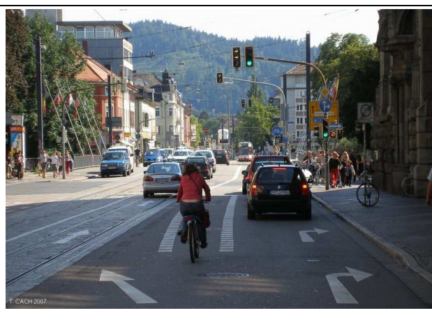
Germania. Corsia di preselezione per la svolta a destra attrezzata per i ciclisti
