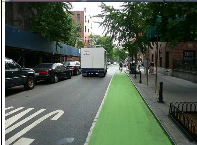
Banda ciclabile su fondo colorato in strada a senso unico. Nel caso in questione sarebbe stato possibile adottare la normale segnaletica da Codice. Lo si riporta per evidenziare la scelta corretta di collocare la sosta sul lato sinistro della strada per agevolare e rendere più sicura la circolazione dei ciclisti.
