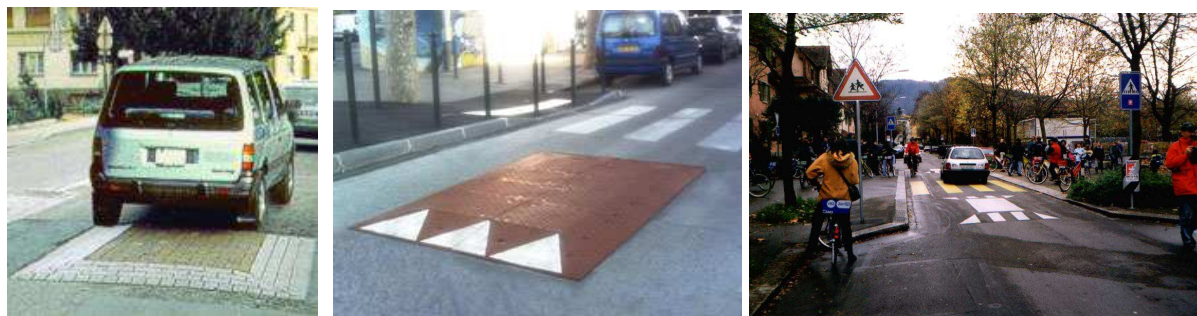
Esempi di cuscino berlinese: il dispositivo di moderazione permette il passaggio in piano dei veicoli a due ruote.
