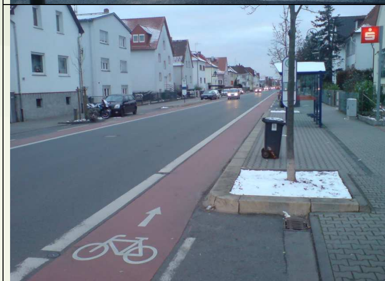
Banda ciclabile di geometrie ridotte delineata con striscia di margine continua e colorazione del fondo.
