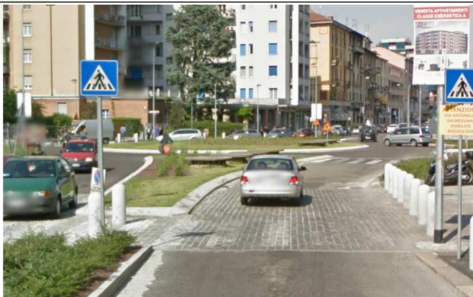
Milano, piazza Gambara. L'attraversamento rialzato, realizzato in massetti di porfido posati 'a correre' in senso longitudinale, provoca un pericoloso 'effetto rotaia'.
