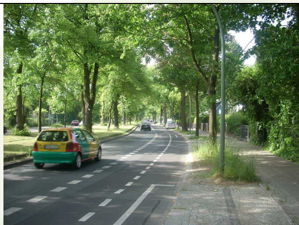
Dahlem (Berlino). In assenza delle dimensioni minime per segnare le due corsie si è correttamente inserita la fascia ciclabile, oltre ad alcuni stalli di sosta
