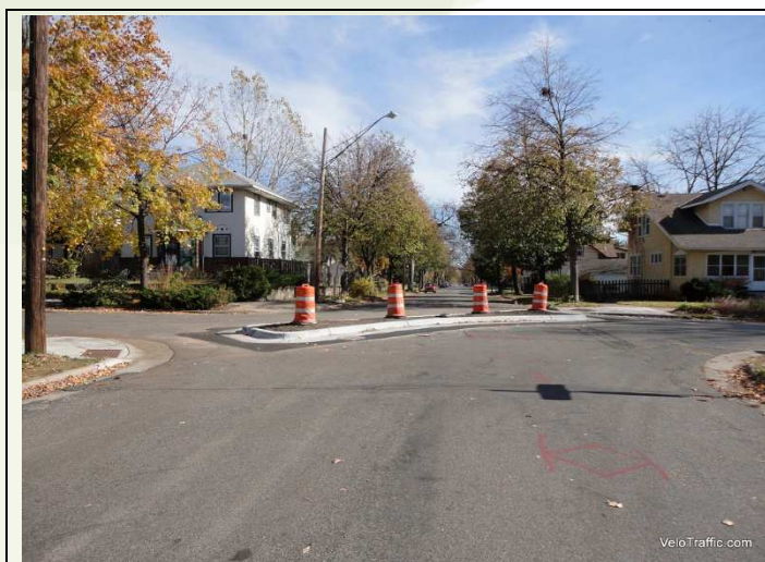
Esempio di diagonal diverter. Tratto da "Pedestrian safety guide" della Federal Highway Administration - USA
