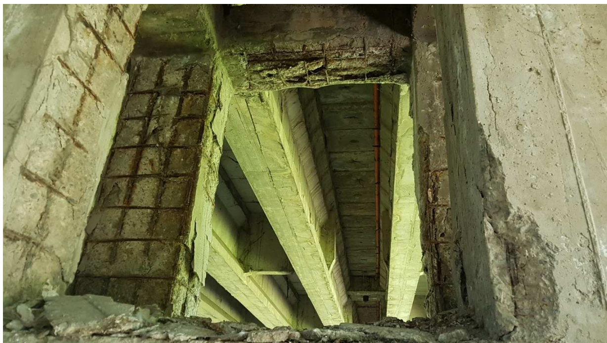
Foto 5: Vista del degrado pile e travi centrali.
