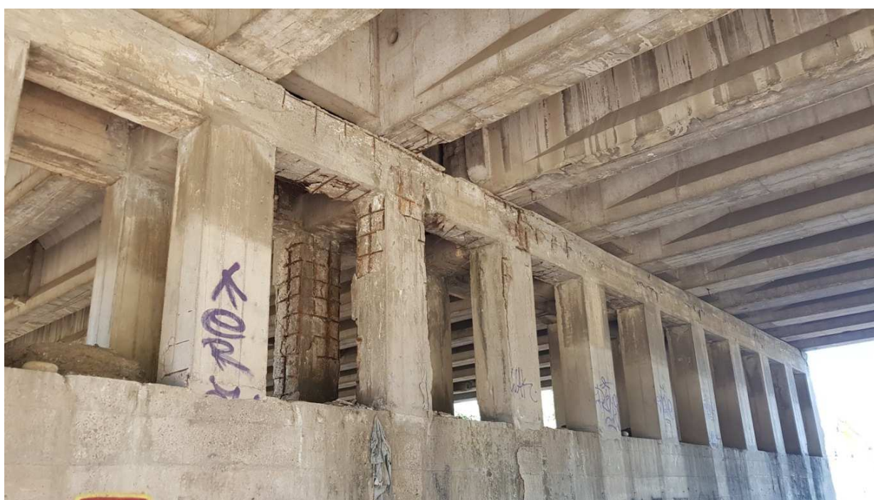
Foto 4: Vista del degrado pile e travi centrali.
