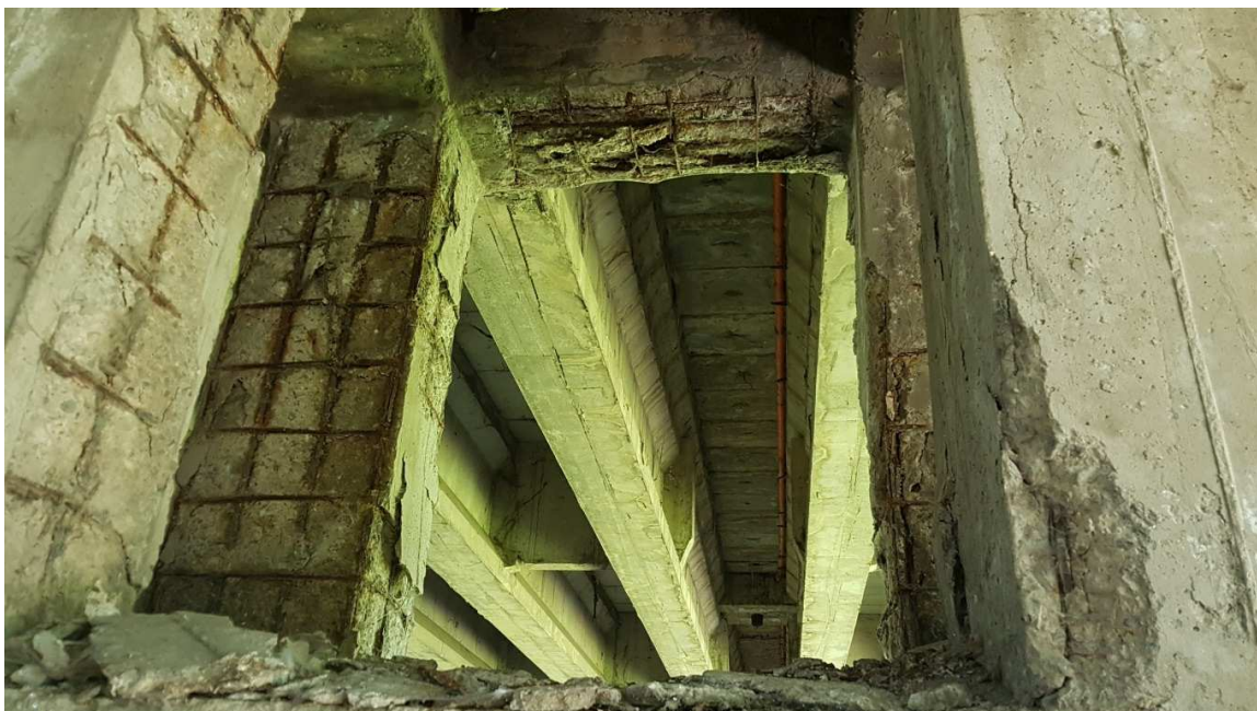
Foto 5: Vista del degrado pile e travi centrali.
