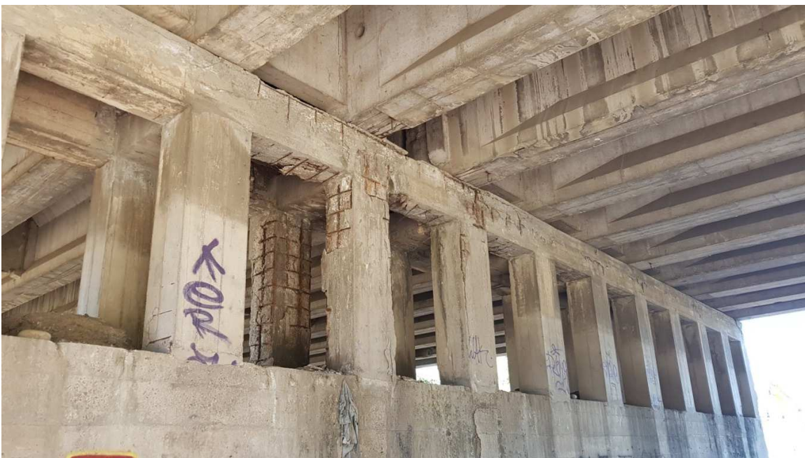
Foto 4: Vista del degrado pile e travi centrali.
