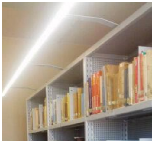
Immagine esemplificativa del sistema di illuminazione integrato a led
