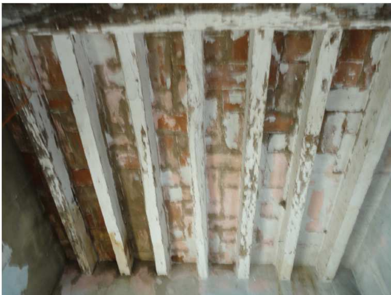
LOCALI:ripostiglio, bagno,pranzo, cucina, deposito,solaio in travetti in legno con sovrastante pianelle in laterizio
