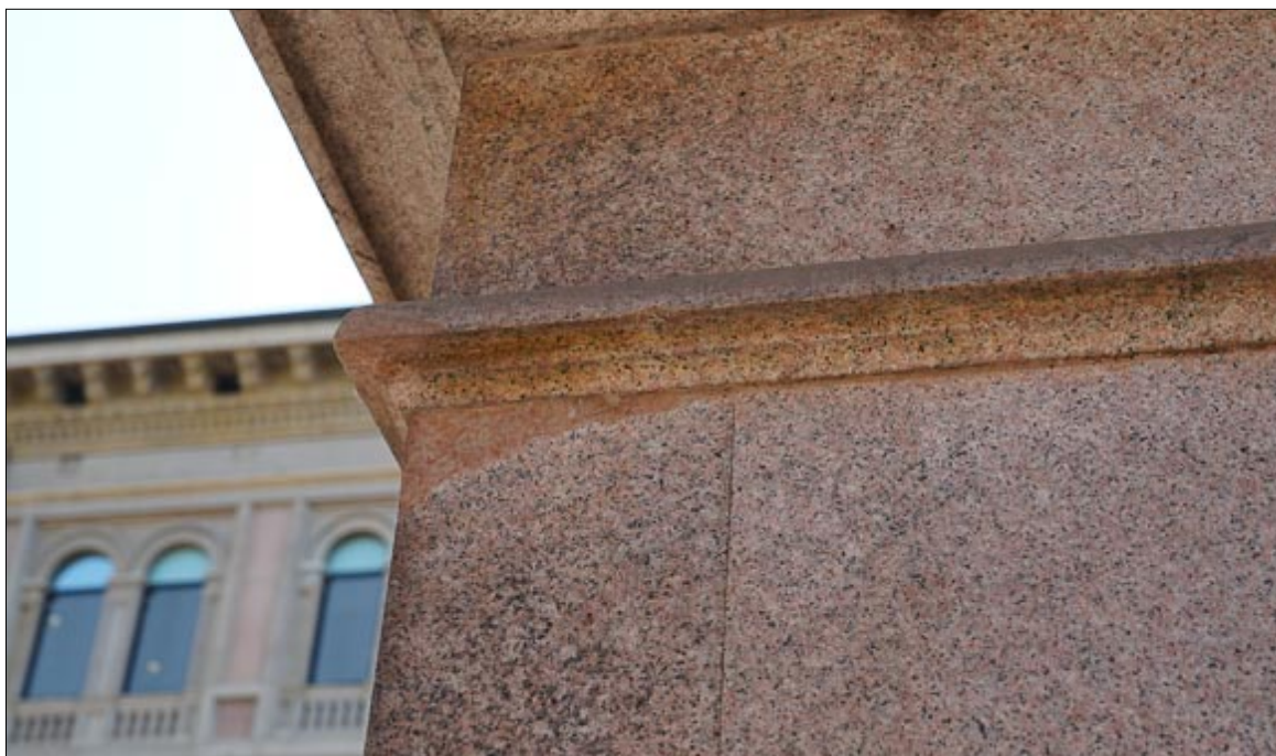
Lacune integrate e accompagnate cromaticamente sullo spigolo Nord Ovest del basamento
