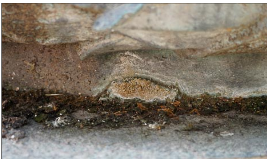
Zona di interfaccia tra bronzo e granito. Si noti la linguetta di piombo per la stabilizzazione del monumento coperta di concrezioni.
