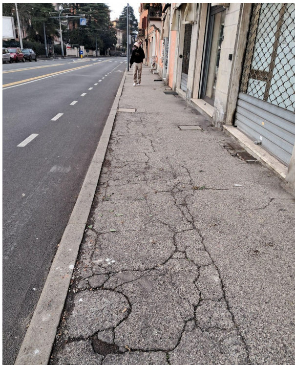
13 – Vista del marciapiede civ. 128
