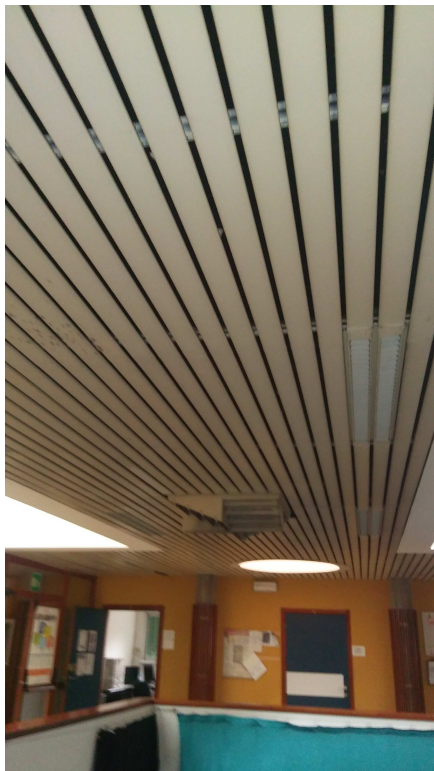
Pavimentazione in materiale plastico Controsoffitto P1 in doghe d'acciaio
