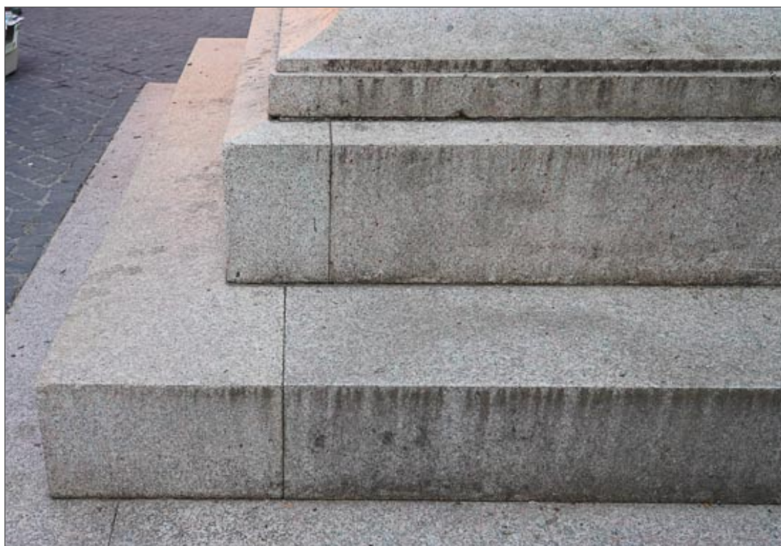
Dettaglio dell'assemblaggio dei differenti conci del basamento evidenziati dalle committiture
