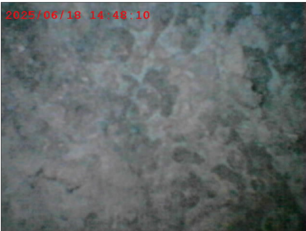
Immagine catturata in endoscopia. Risulta visibile la morfologia irregolare della superficie interna del piedistallo in bronzo e la presenza di corrosione attiva.
