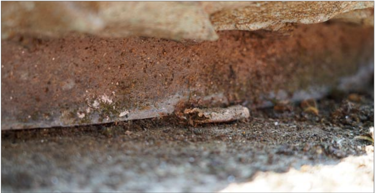
Zeppa stabilizzatrice in piombo all'interfaccia tra bronzo e granito
