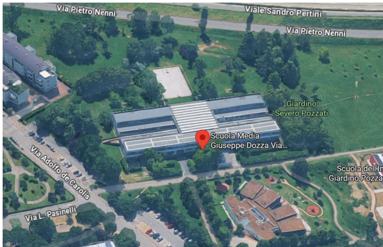
Foto aerea dell'edificio oggetto d'intervento
