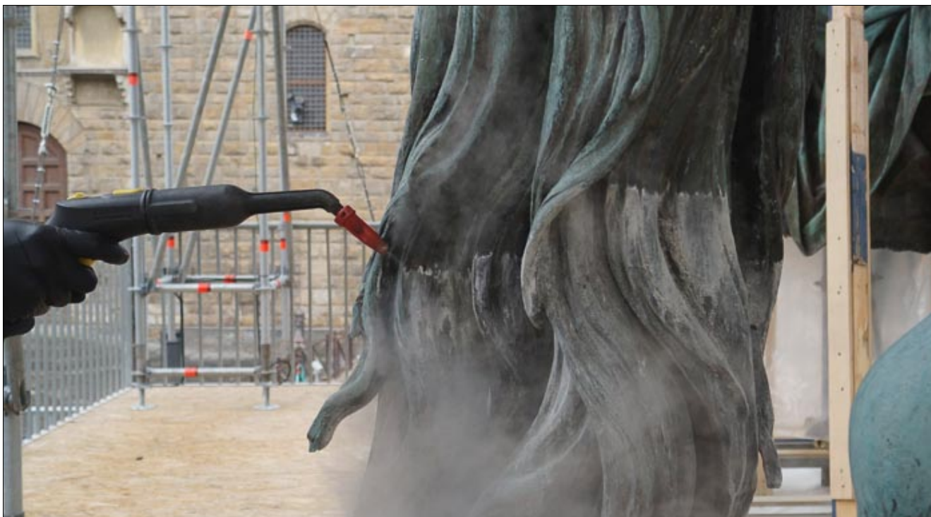
Lavaggio superficiale con vapor d'acqua a pressione - Statua equestre di Cosimo I de Medici, Firenze
