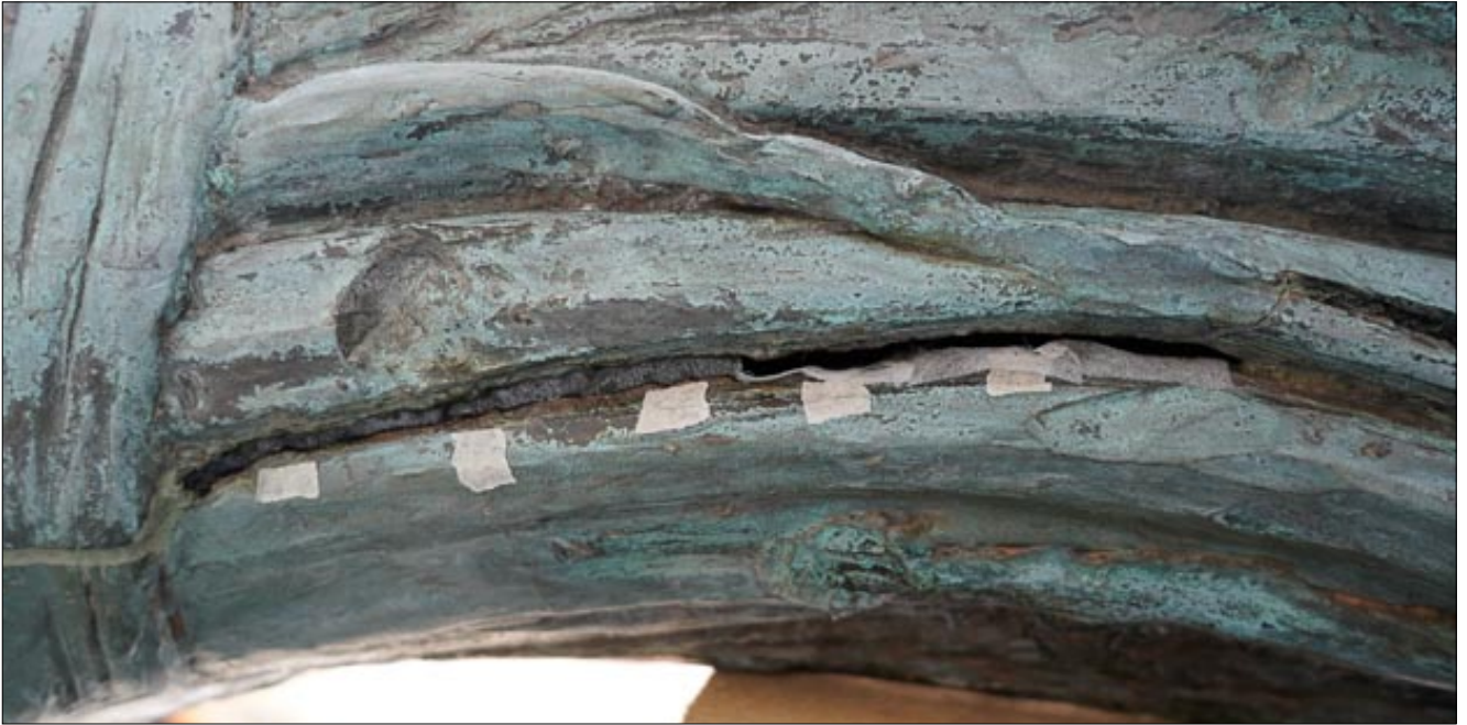
Stuccature fessurazioni con applicazione di rinforzi di tessuto non tessuto- Statua equestre di Cosimo I de' Medici, Firenze
